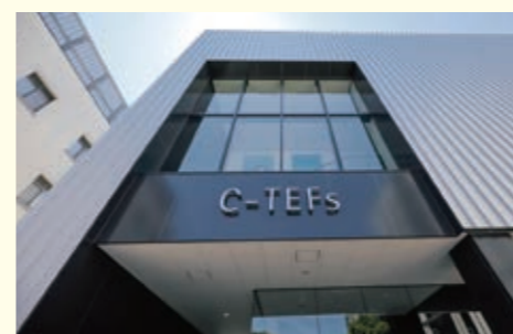
オープンしたC-TEFs。地上2階建、延べ床面積 約3,000平方メートル
